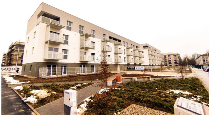
Nova celjska Singenska ulica. Zaključek celotnega projekta je predviden decembra 2022. Foto Uroš Urlep
