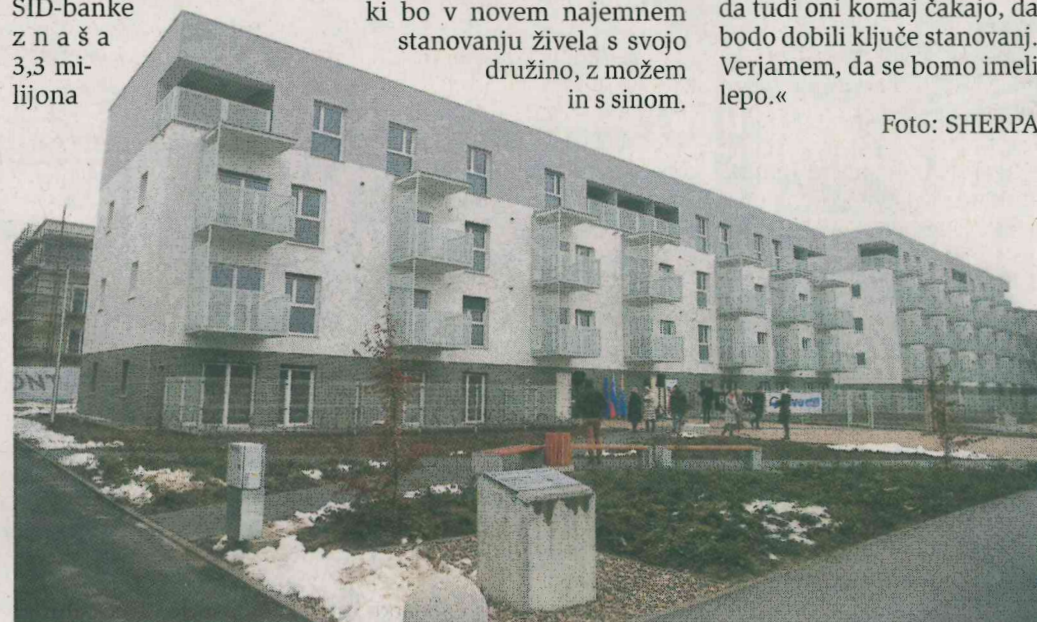
Nova soseska s 142 stanovanji v šestih stanovanjskih blokih in z garažno hišo bo približno 400 Celjanom zagotavljala sodoben bivalni standard, saj bo zgrajena po smernicah trajnostno učinkovite gradnje.
