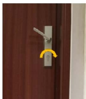
zavrtimo ključ do zaklenjenega položaja ključavnice
