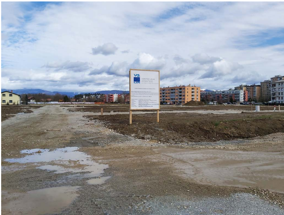
Komunalna infrastruktura je že zgrajena.
